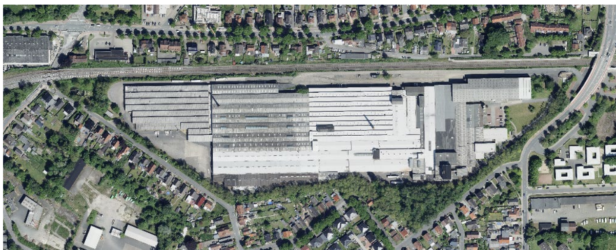
Abbildung 4: Luftbild Steingut-Areal (Quelle: Landesamt für GeoInformation - Bremen 2021)
